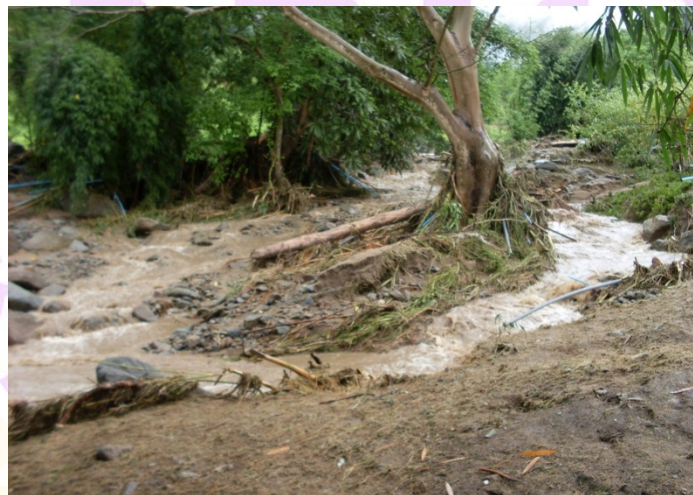
รูปที่ 1 สภาพความเสียหายที่เกิดจากน้ำหลาก
