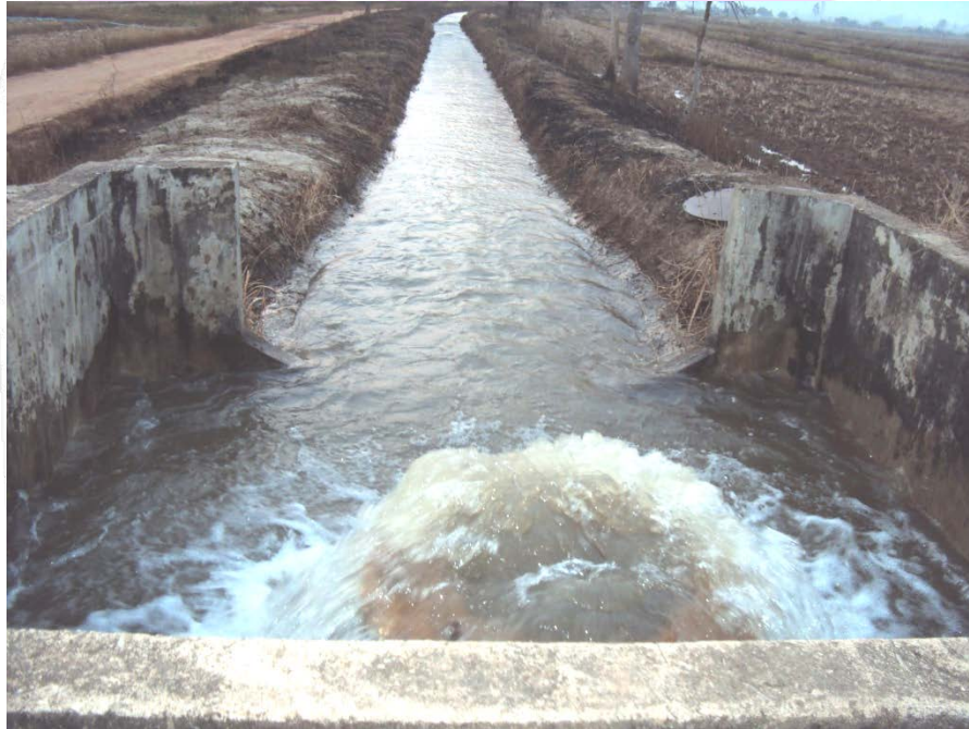
รูปที่ 2 คลองส่งน้ำตาดคองกริต
