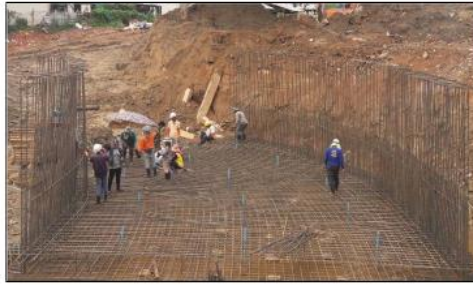
งานลงเหล็กพื้นและผนัง
