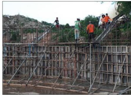
งานเทคอนกรีตผนัง
